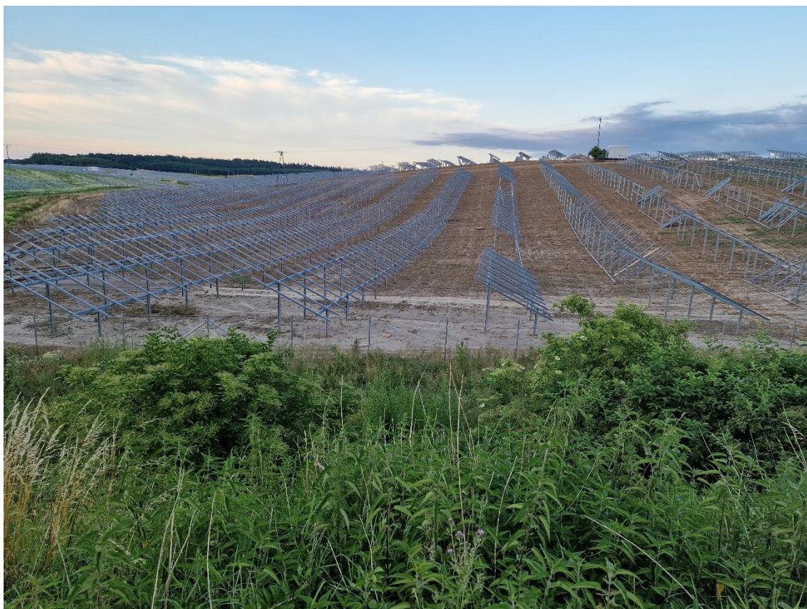
Fotografia 3. Jedna z farm fotowoltaicznych w rejonie badań, etap budowy.
